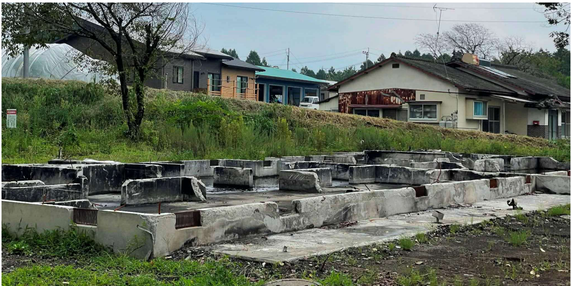
図表 4-38 大利団地焼失住戸跡
