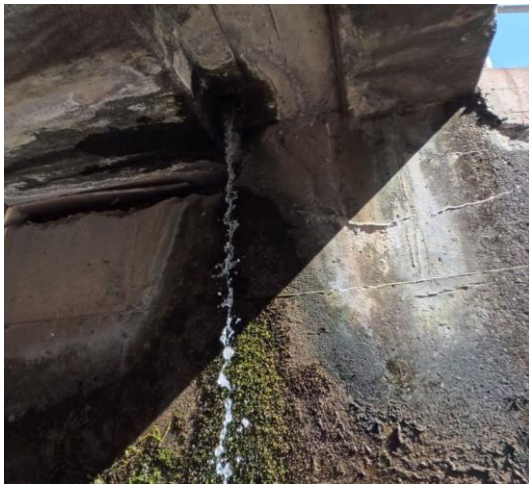
写真 4-4 防水槽の越流水排水状況
