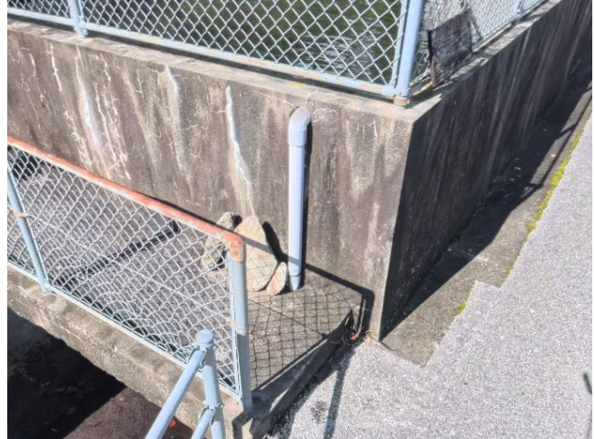
写真 4-4 防水槽の越流水排水状況
