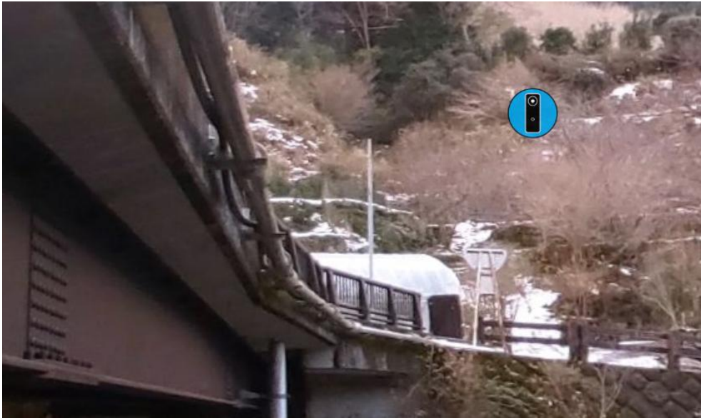
写真 4-5 橋梁点検で合わせて撮影した管路の状況
