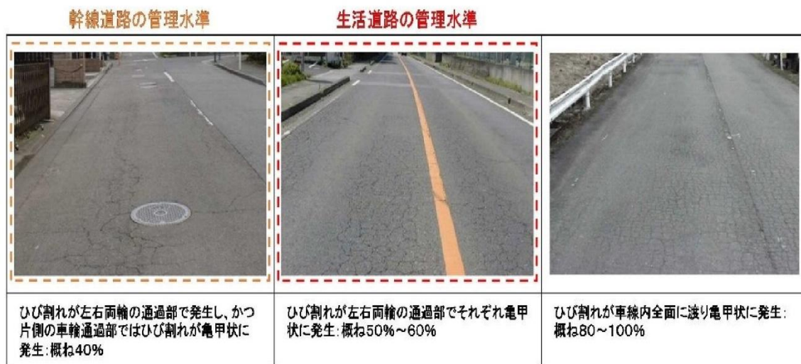
図 4-26 ひび割れ率に関する判定例
