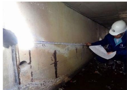
ひびわれ注入工 確認状況
