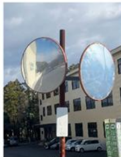
写真-6 〈5-381〉 笠無し、支柱の腐食
