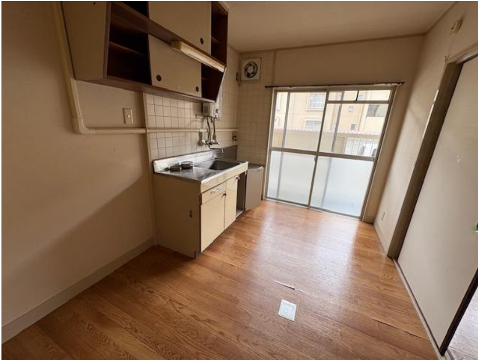
図 25 米谷第 2 住宅内装（改修済み）
