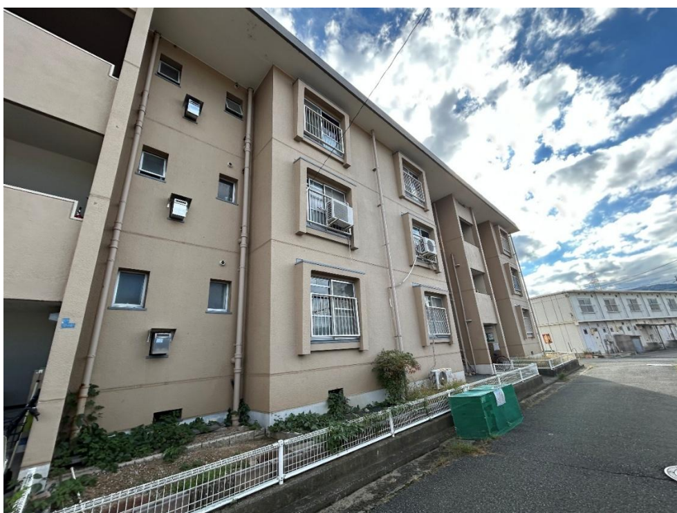
図24 米谷第2住宅外観
