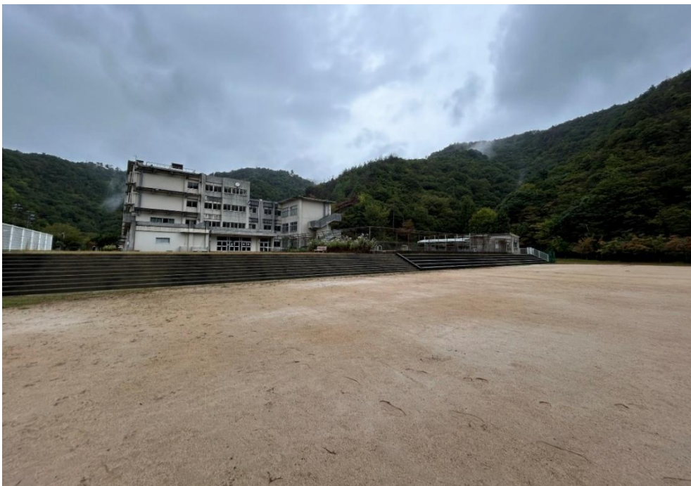
図 47 グラウンドから見た旧中山五月台小学校校舎
