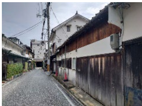
図表 2-8 軒裏の劣化（北側）
