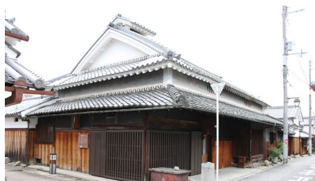
図表 2-5 旧東奥谷家住宅 外観
