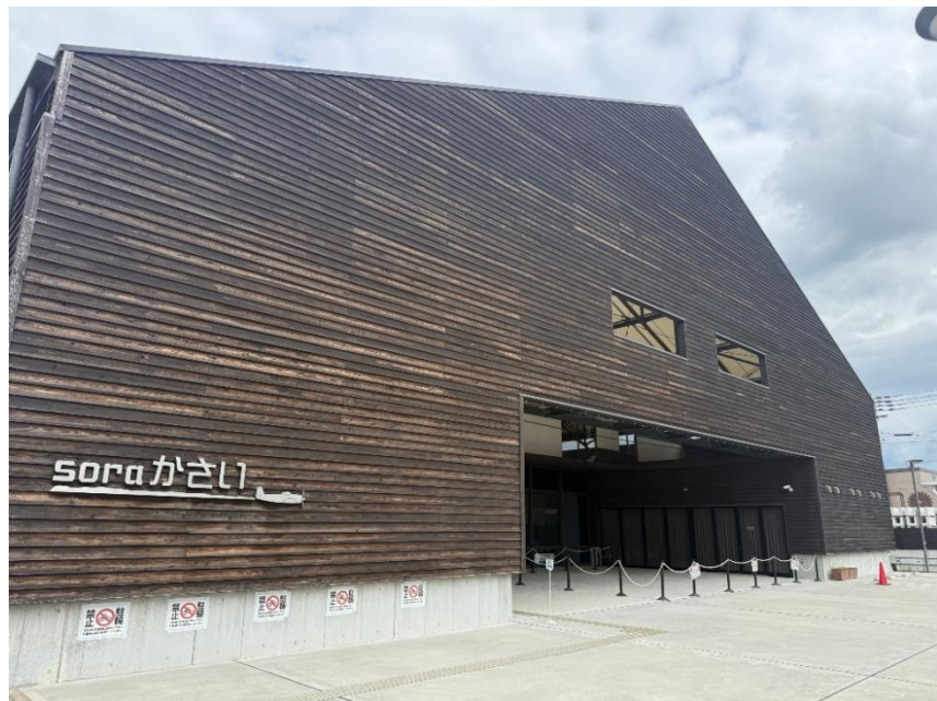
図 4-5 Sora かさい（地域活性化拠点施設）
