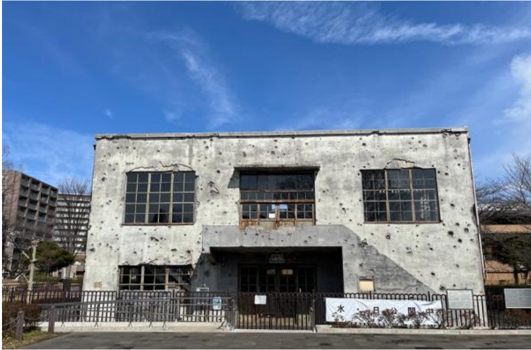
図 2-19 変電所 外観（建物前方）
