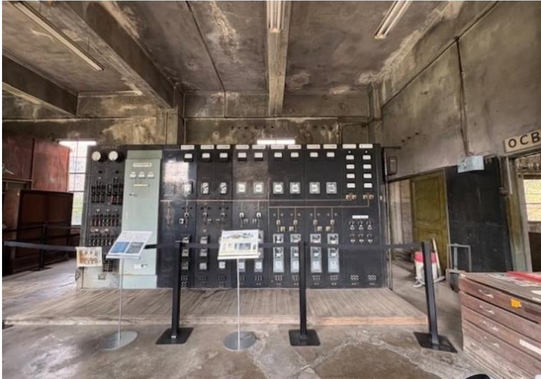
図 2-23 変電所 2階展示スペース
