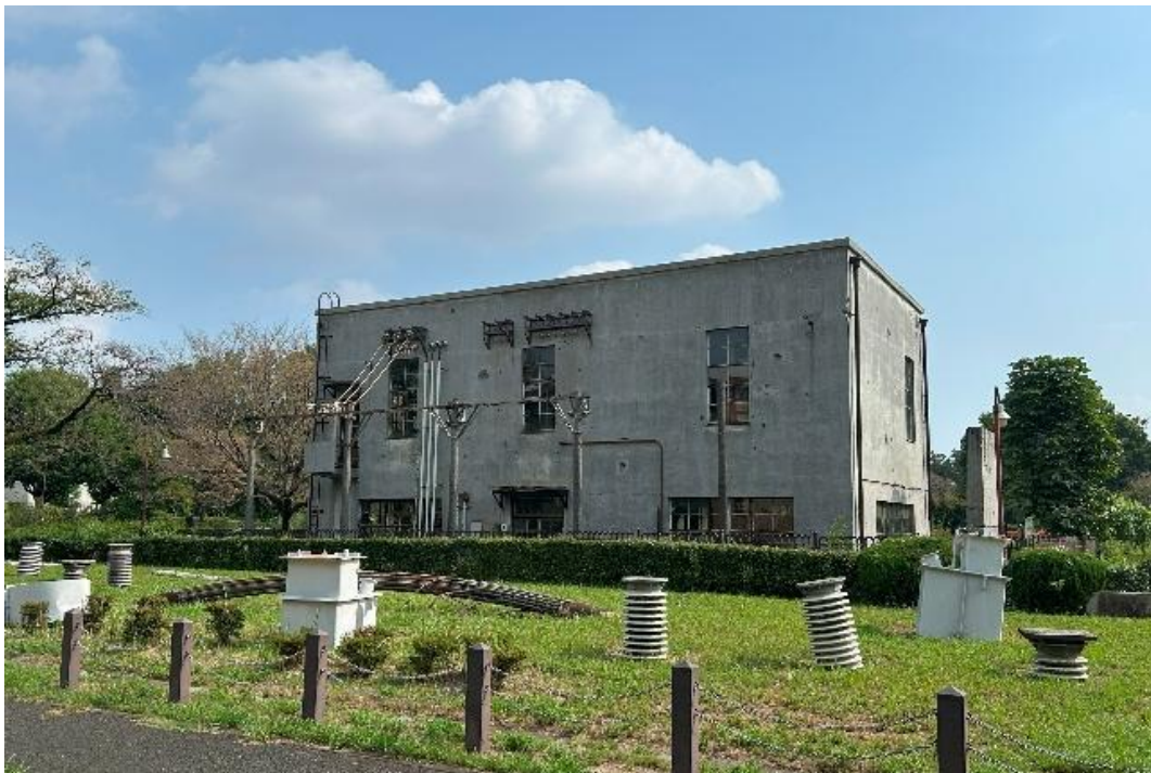
図 2-20 変電所 外観（建物後方）
