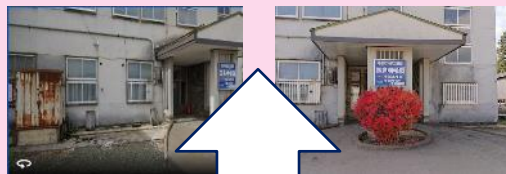
旧増田町診療所（伝統的建造物）
