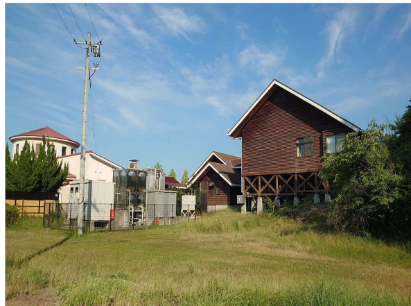
▲ 裏側外観（左が温泉施設、右が別館）
