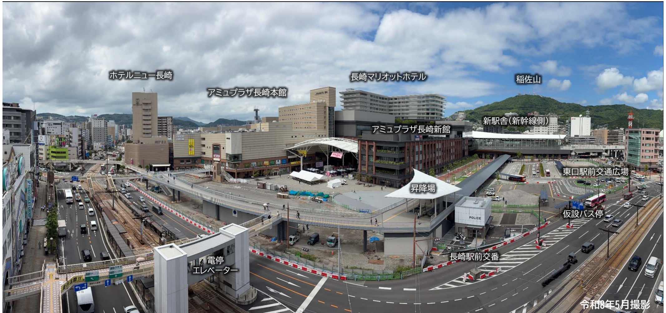
長崎駅東口の施工状況
