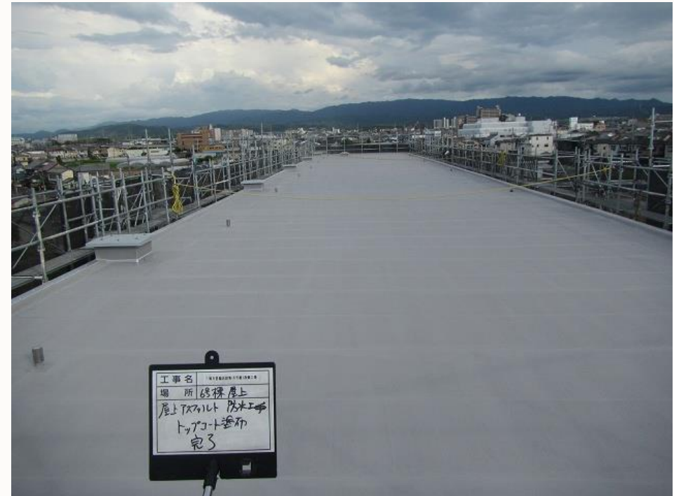
屋上防水改修工事後
