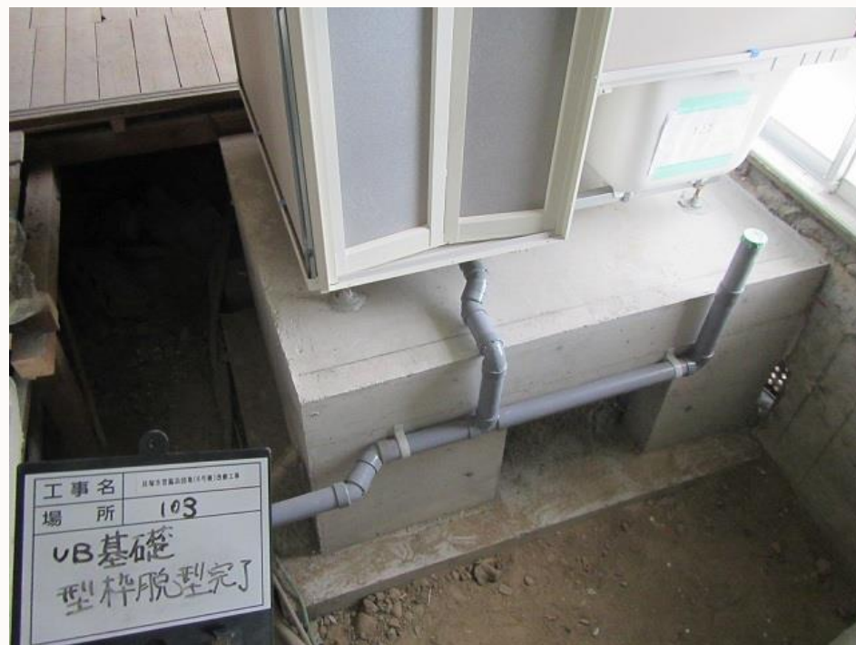
ユニットバス新設のためコンクリート台座を設置
