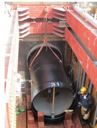
水道管路の更新イメージ
