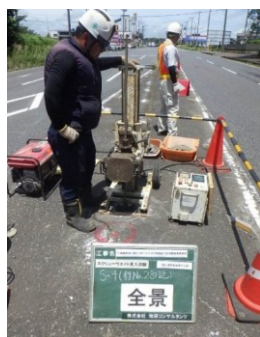
貫入試験による空洞調査
