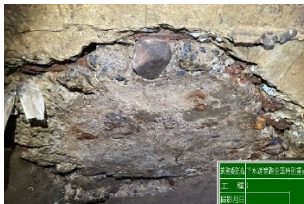
管の破損・クラックから緊急度 I と判定
