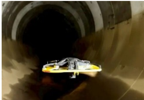
ドローンによる目視調査
