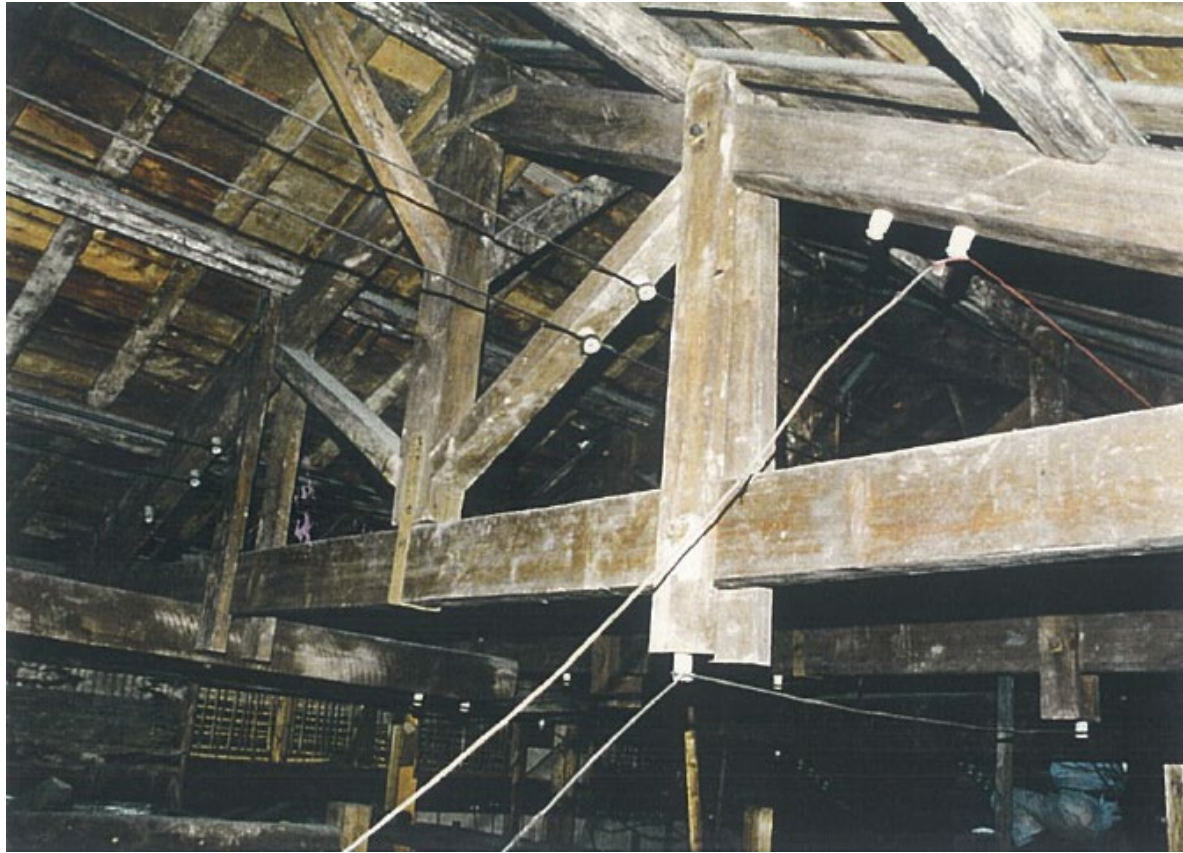
屋根裏の状況
