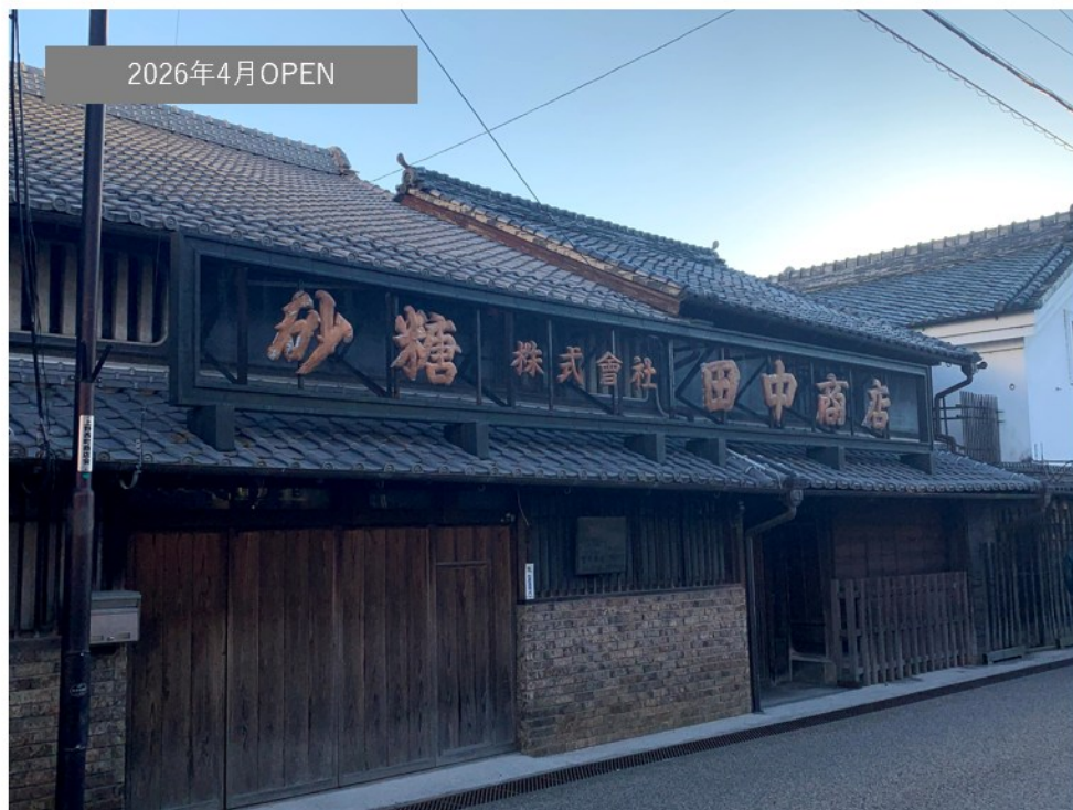
NAIKI棟 (明治期)
