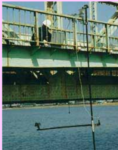
簡易橋梁点検装置による点検状況
