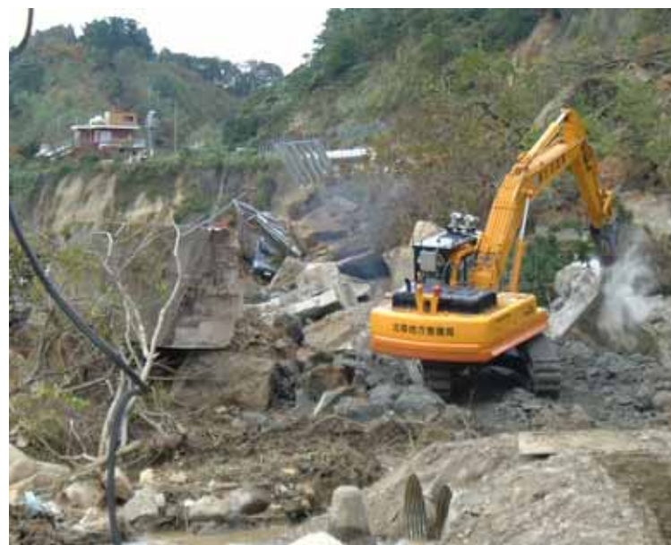
コンクリート構造物の破壊作業
