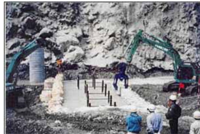
土嚢及びコンクリートブロック積作業
