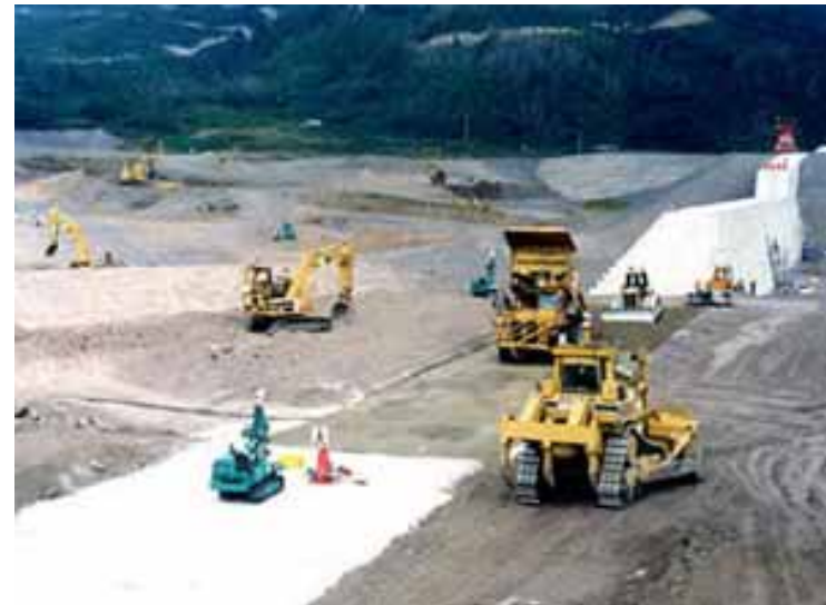
コンクリート砂防ダムの構築
