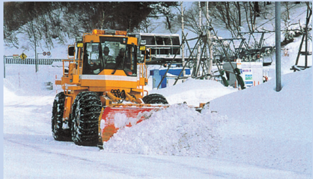
除雪ドーザによる作業
