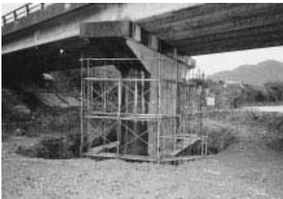
写真 4 アンカー定着状況
