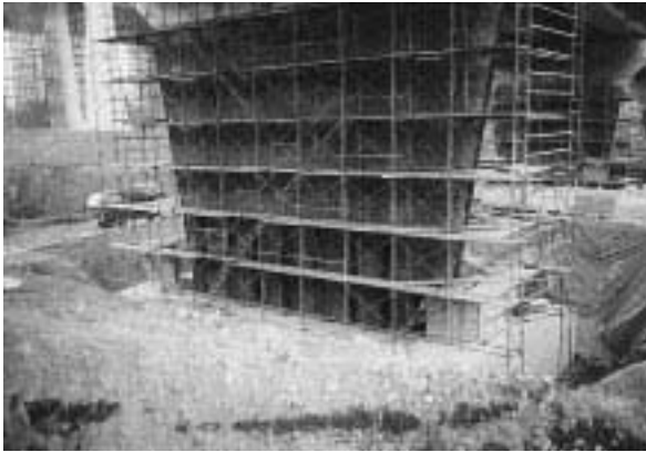
写真 2 足場設置状況
