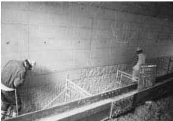
写真 3 下地処理(チップング)状況
