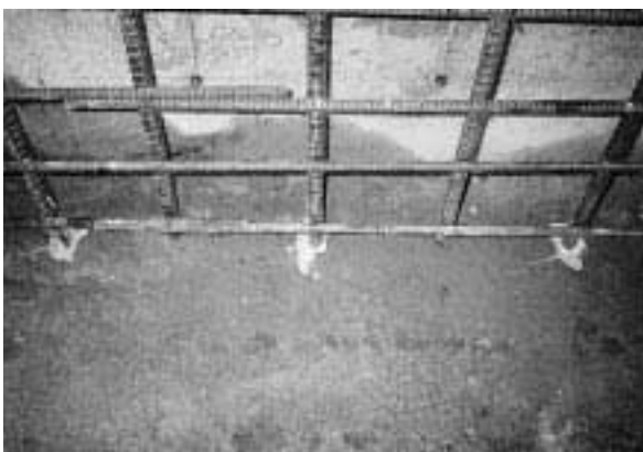
写真 4 アンカー定着状況
