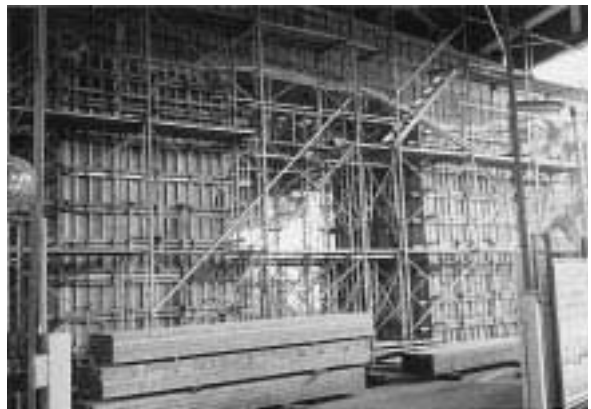
写真 7 コンクリート打設
