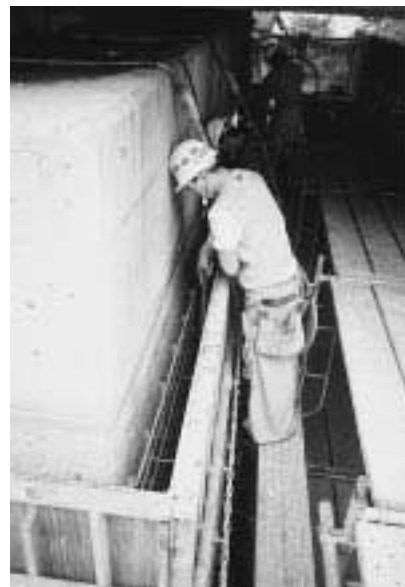
写真 7 コンクリート打設
