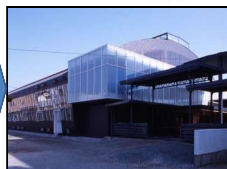
改修後屋内運動場外観
