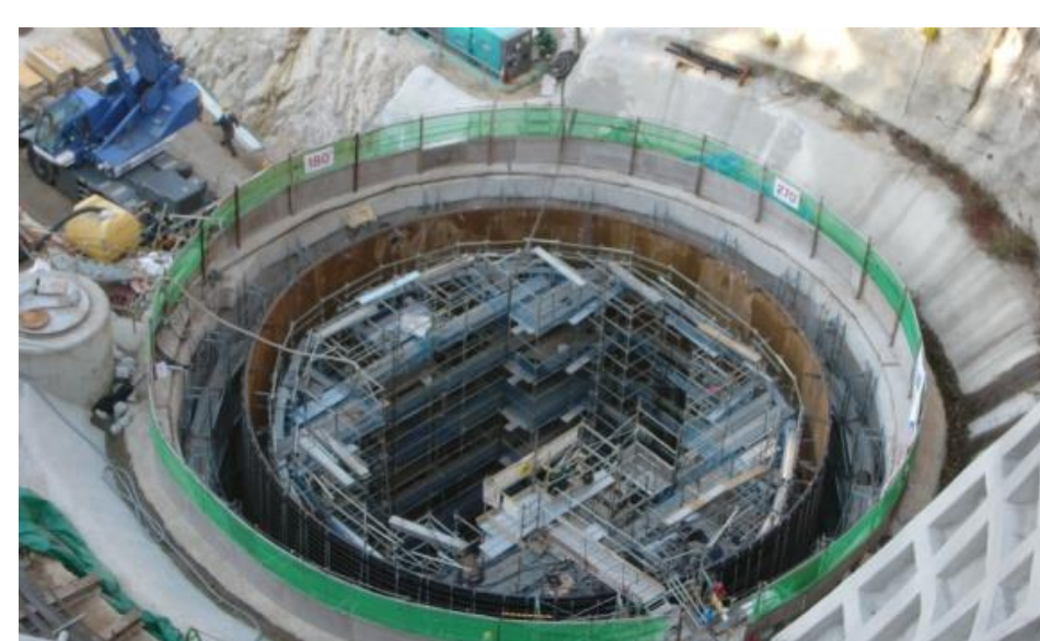
新設タンク施工状況
