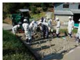
コンクリート打設
