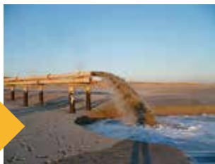
運転後：平成 30年 6月
