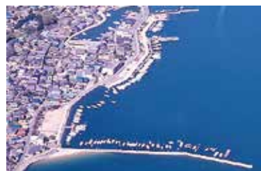
PB係留施設整備前(港内)
