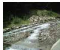
豪雨直後の状況（施工から2年後）① 流出した土砂が堆積しているが、木工沈床の各段が調節機能を発揮している。
