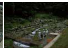
施工から4年後の状況 土砂の堆積・流送を繰り返して、渓床を安定させながら、自然流路のような状態になっている。
