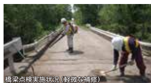
橋梁点検実施状況(軽微な補修)
