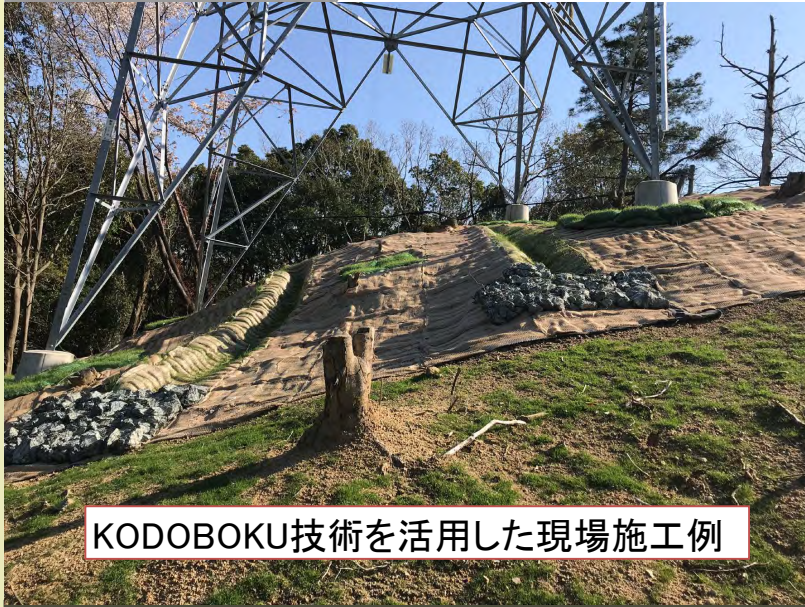
ストーンバッグによる流末処理
