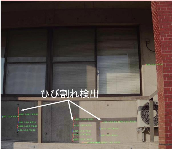
【AIによる判別結果の一例 (4Kカメラ画像を用いたひび割れ検出)】
