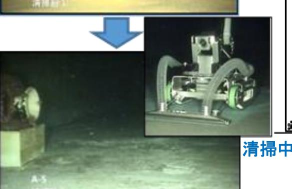
配水池については 縮小してイメージ図化 しています ロボット制御装置 TVモニター 排水ホース (フロートホース) 水中ロボット ポンプ 水中ロボット 沈澱槽
