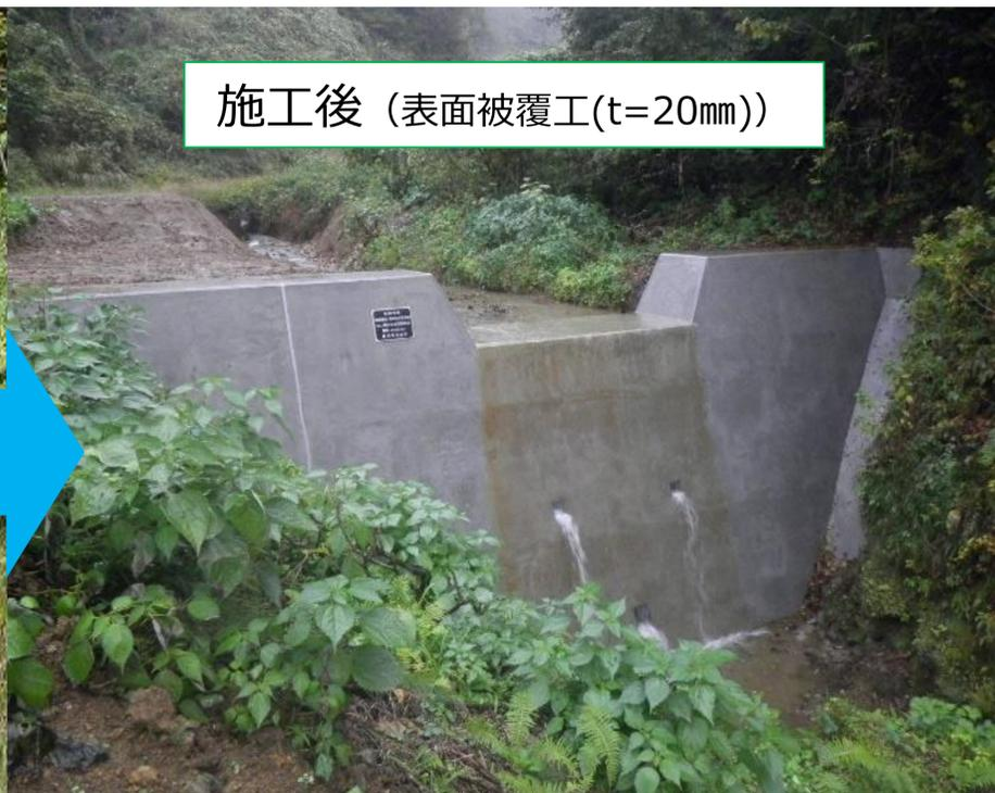
施工後 (表面被覆工(t=20mm))
