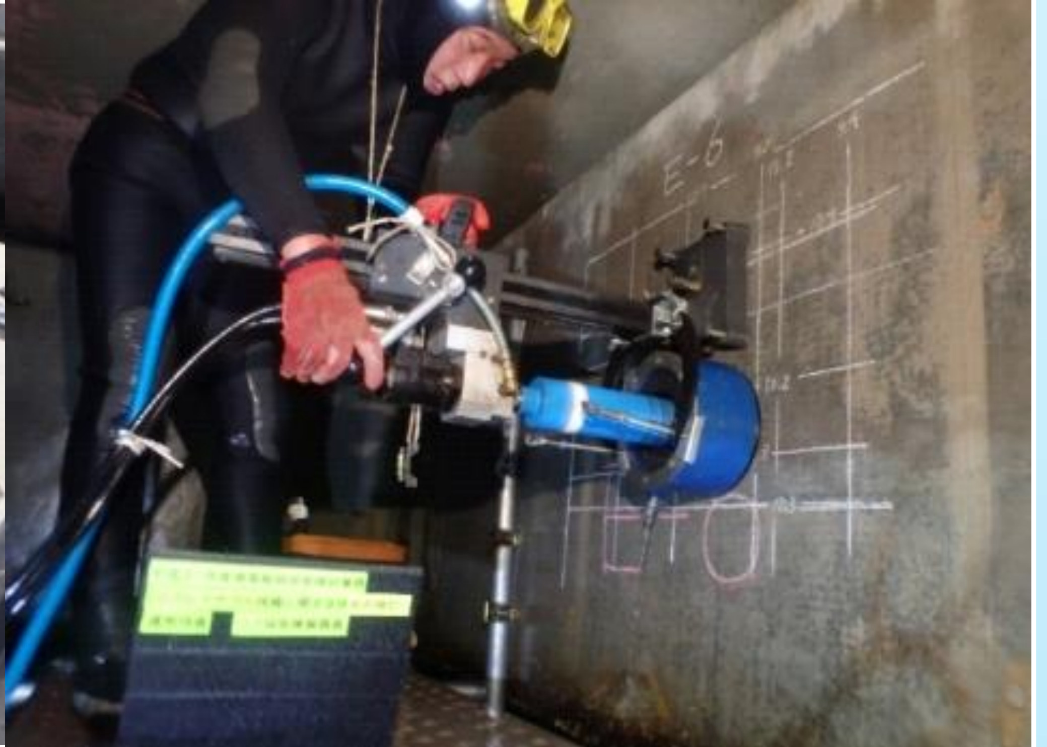
暗所による施設点検状況
