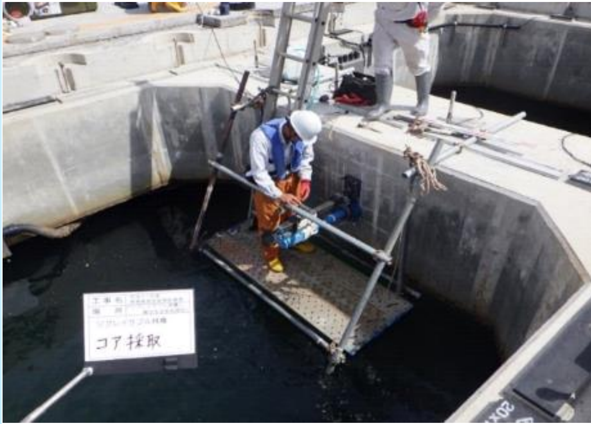
上床版撤去による施設点検状況
