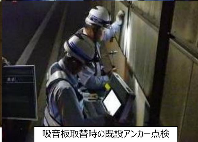
吸音板取替時の既設アンカー点検
