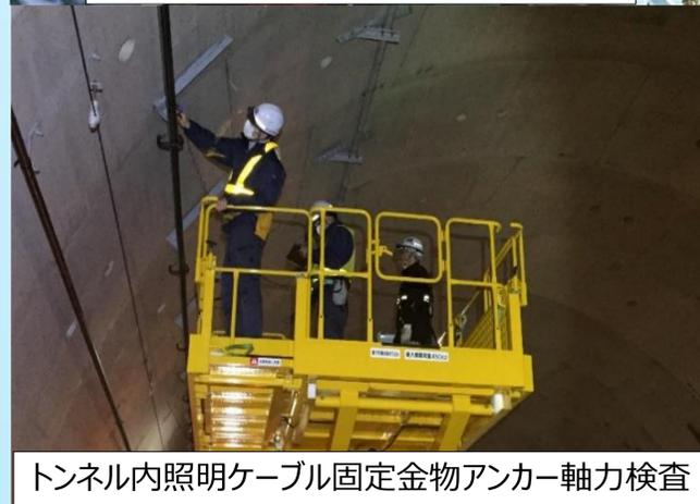
トンネル内照明ケーブル固定金物アンカー軸力検査
