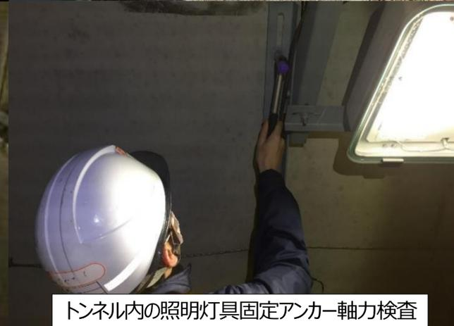
トンネル内の照明灯具固定アンカー軸力検査
