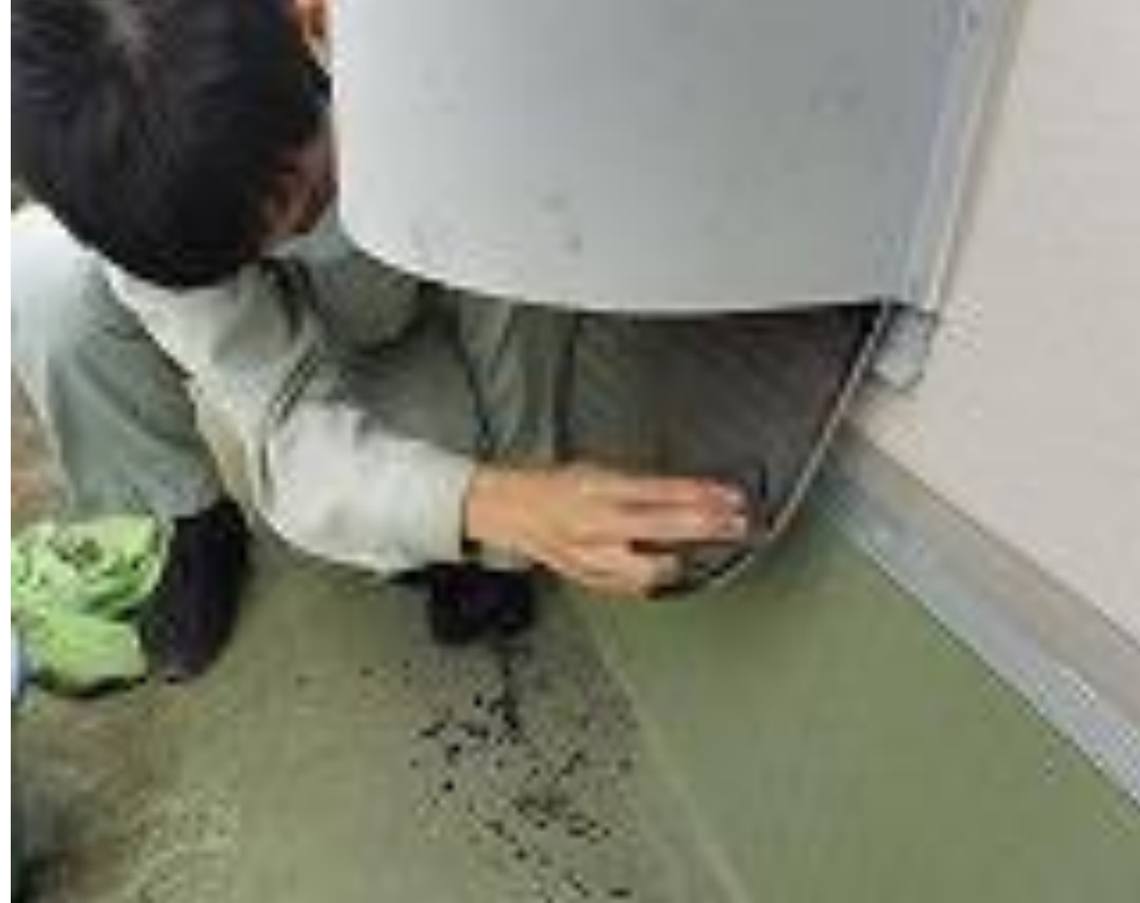
職員D I Y 防虫網の目詰まりの除去
