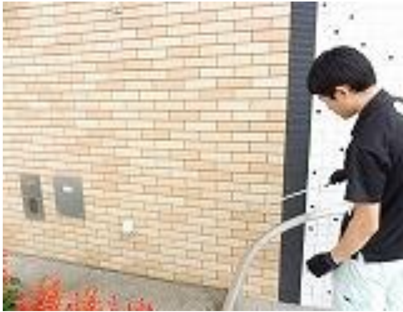
12条点検実施状況 タイルの打音検査
