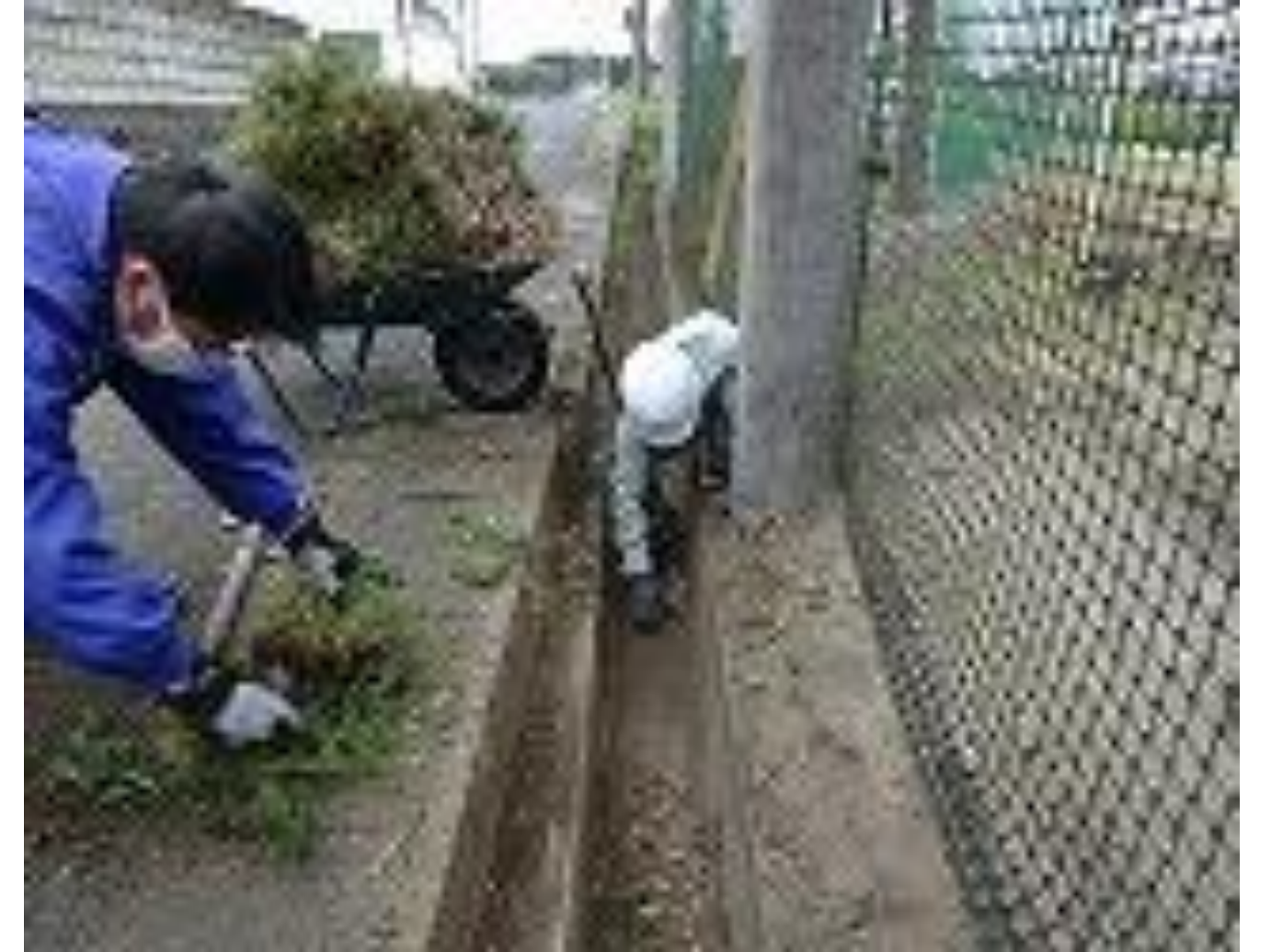
職員D I Y 敷地内排水路の清掃
