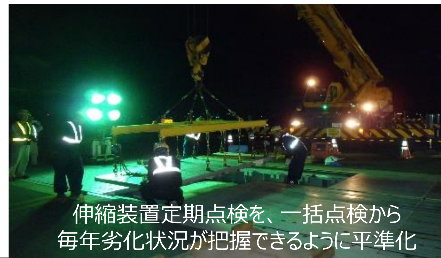
維持管理の簡易性確保のためチタン製 カバープレートを点検足場兼用として採用
