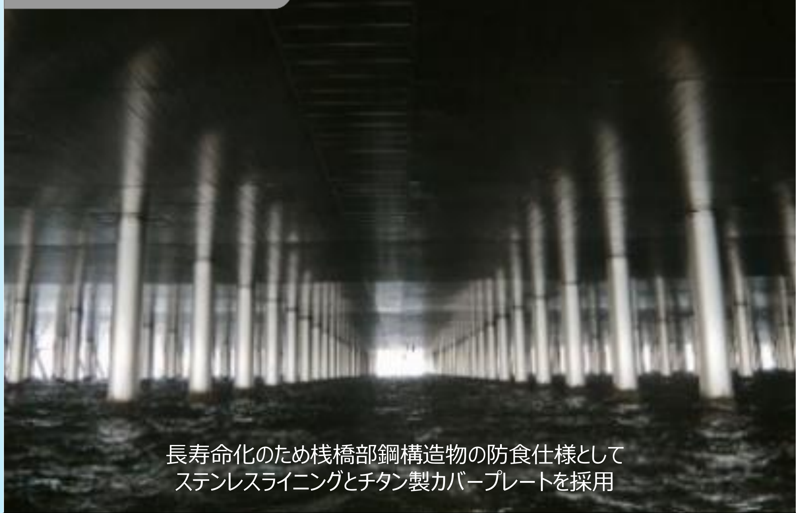
維持管理の簡易性確保のためチタン製 カバープレートを点検足場兼用として採用
