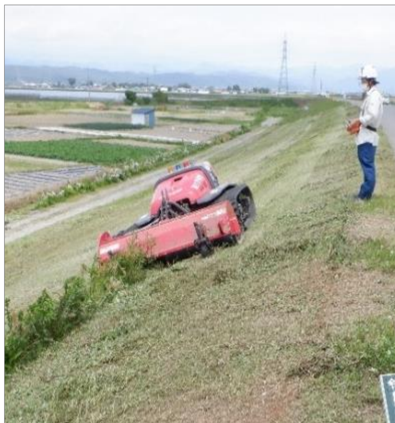
大型ラジコンによる遠隔式除草
