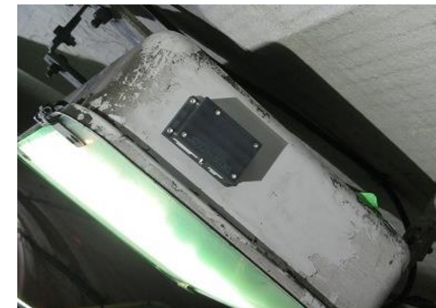
トンネル内照明 取付状況
