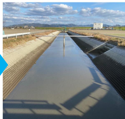
先行排水実施後
