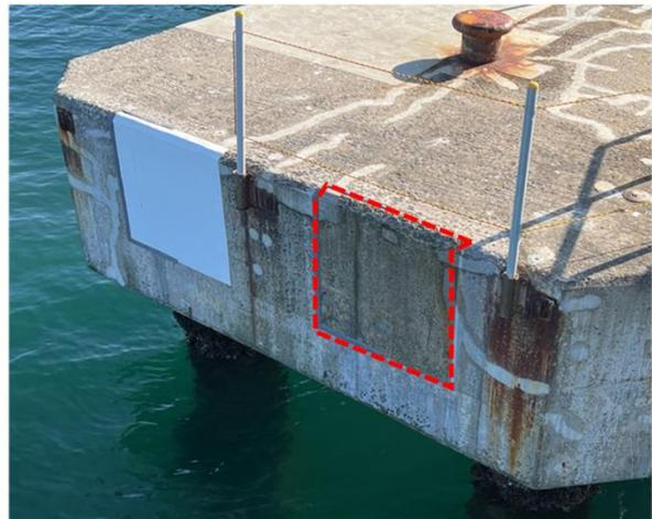
実証実験塗布状況写真（左：栈橋下面、右：ドルフィン側面）
