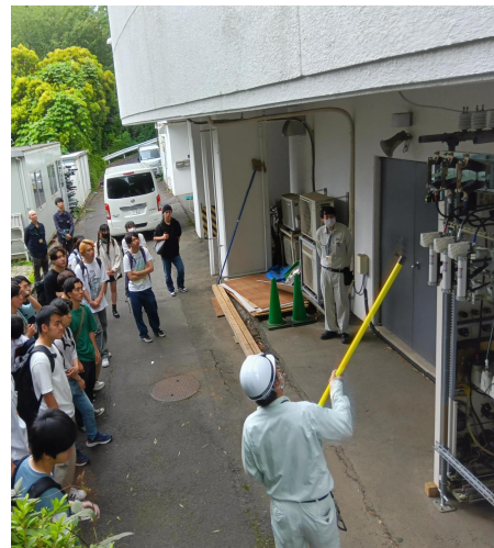
大学生の施設（高圧受電設備）見学
