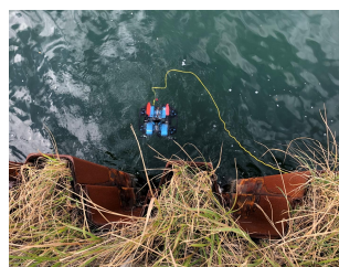
水中ドローン撮影状況
