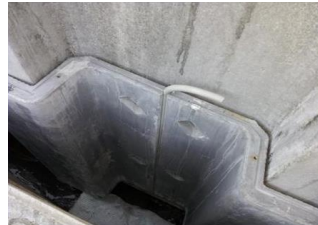
ダクトアルフォームの施工
