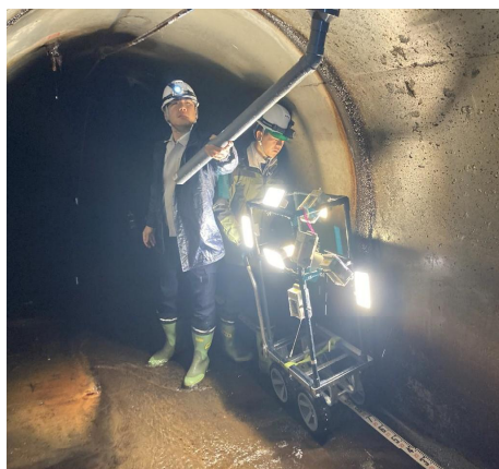
坑内写真撮影作業状況
