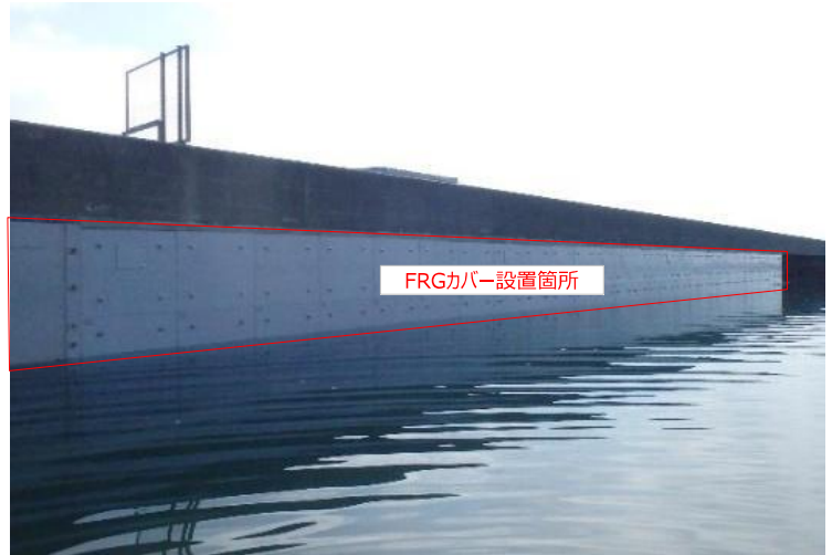
完成全景（補修完了）
