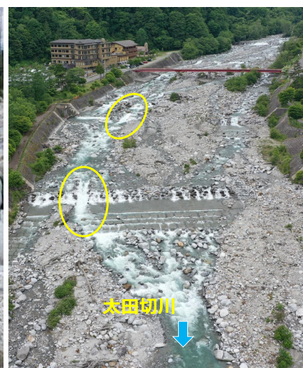
改修された常水路工(魚道)
