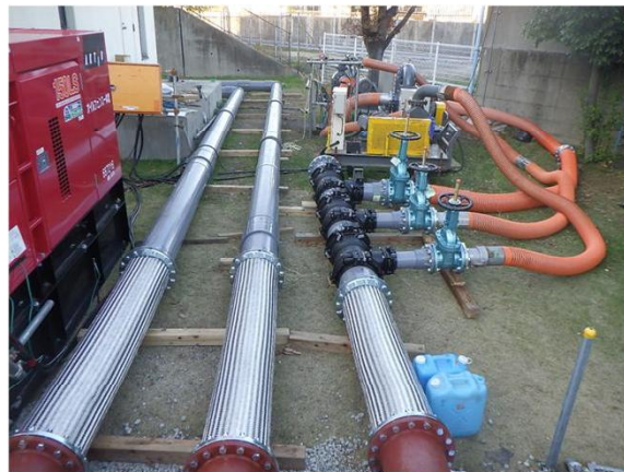
ポンプから仮設排水管への接続状況
