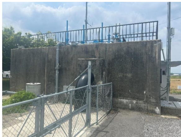
幹線から支線への分水工の写真
