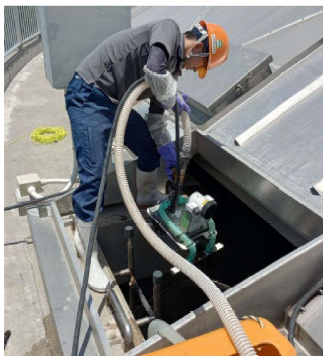
人力で機材を投入
