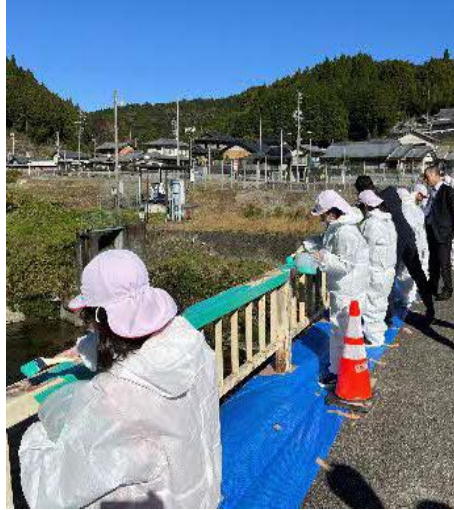
塗装塗替え実施状況
