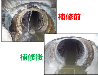
海水混入箇所特定～補修
