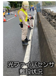
光ファイバセンサ 敷設完了
