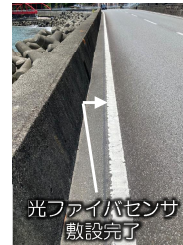
光ファイバセンサ 敷設状況
