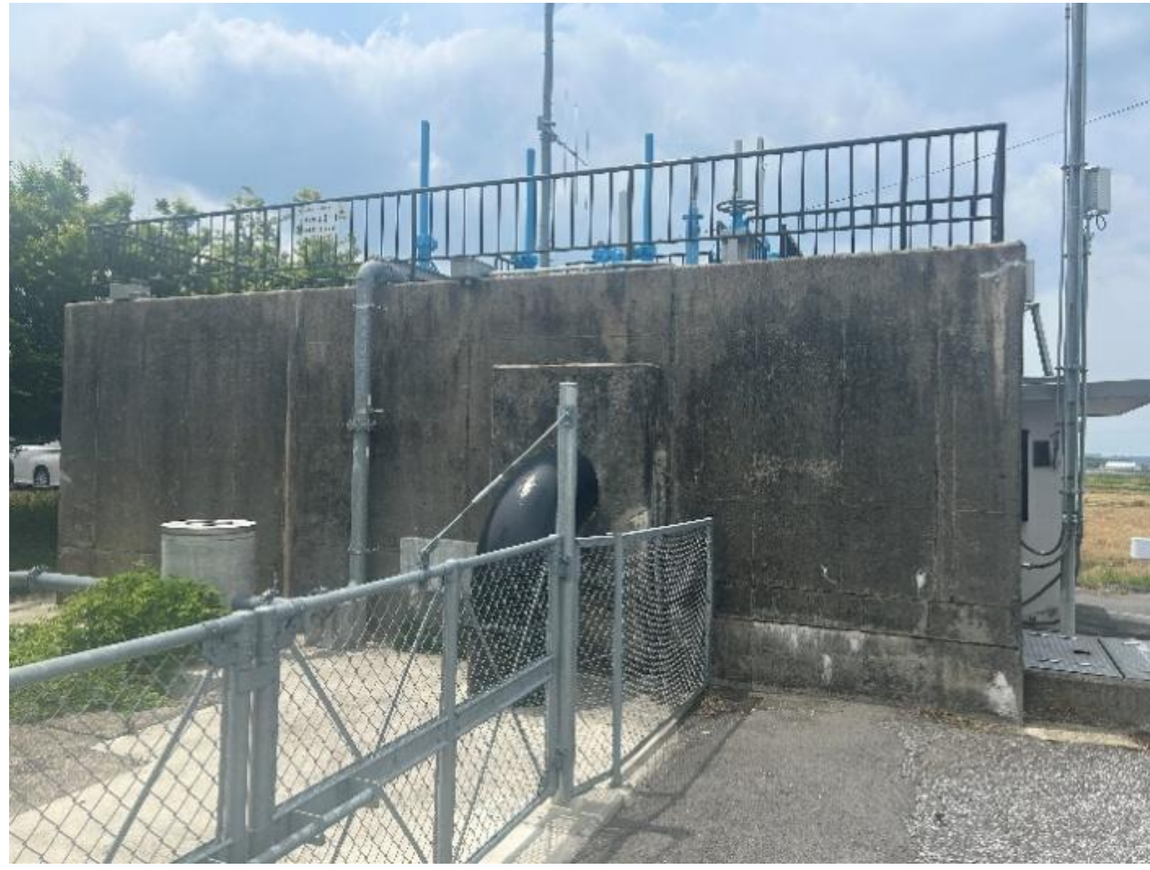
幹線から支線への分土工の写真
