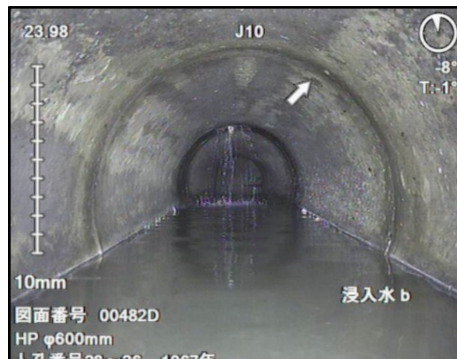
テレビカメラによる詳細調査（侵入水状況）
