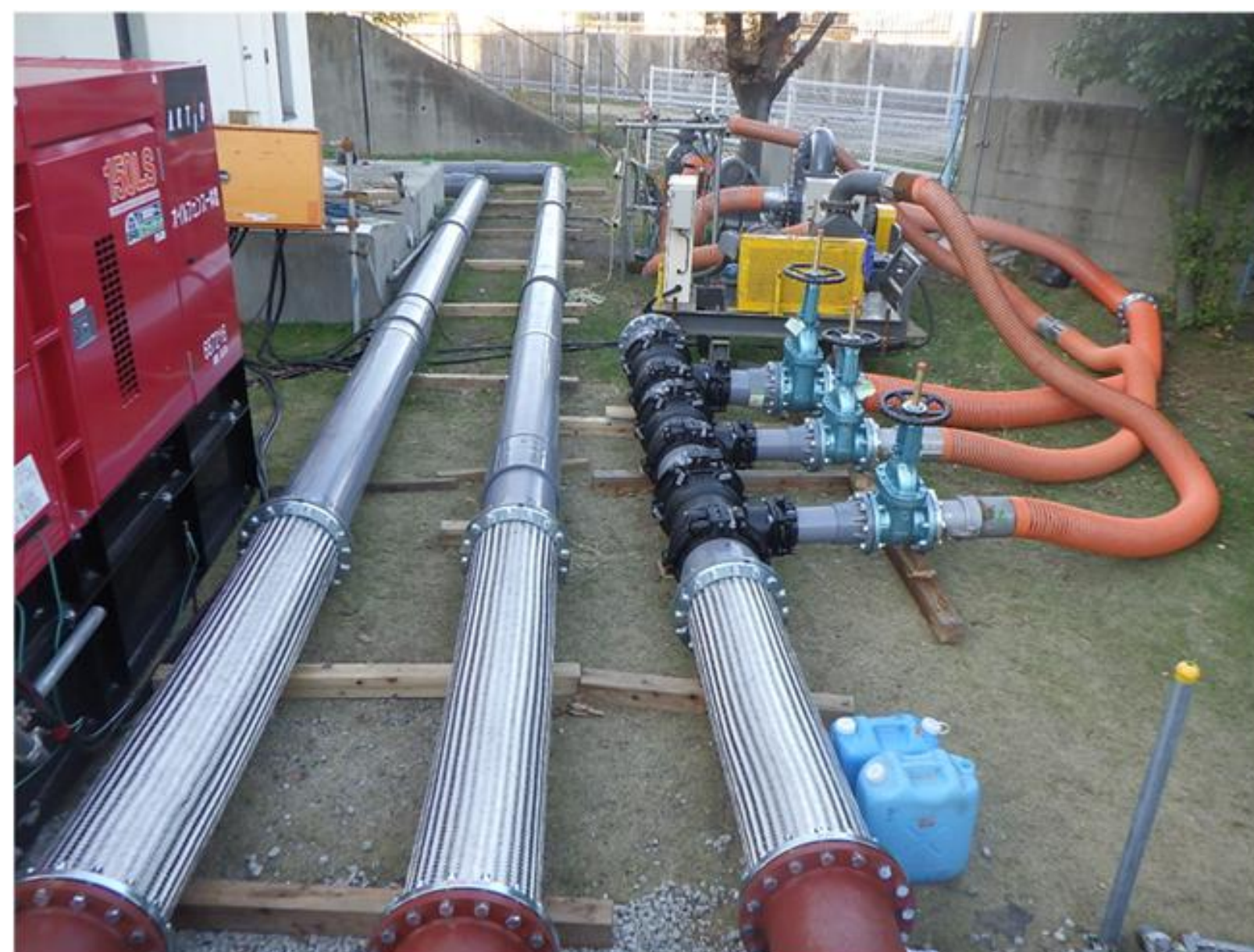
ポンプから仮設排水管への接続状況
