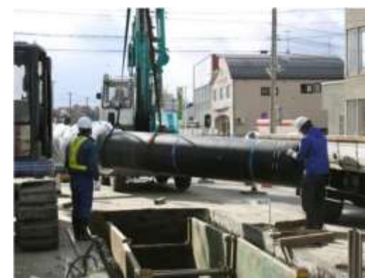
老朽管の布設替工事
