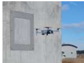
ドローンによる損傷把握
