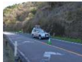
MMS※1を活用した 斜面・のり面点検
