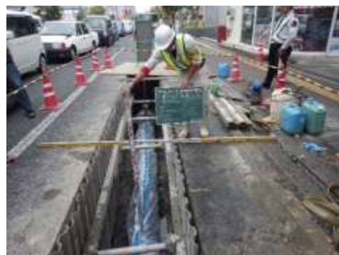
管路の布設替（開削工）
