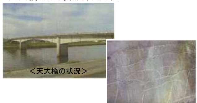
■ 天大橋（鹿児島県薩摩川内市）
