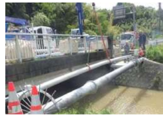
水管橋の更新工事
