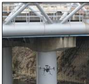
水管橋の点検
